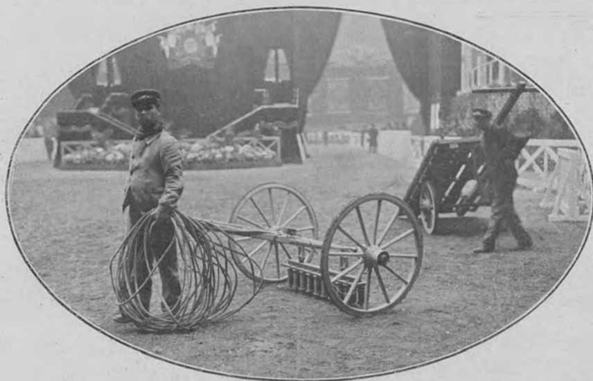
LA MACHINE EMPLOYÉE POUR RAMASSER LES CLOUS SUR LA PISTE
