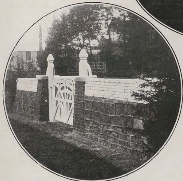
PORTAIL ENTRE DEUX MURS EN PIERRE SURMONTÉS DE BRIQUES (HAUTEUR DU PORTAIL ET DES MURS 1 m 40)
