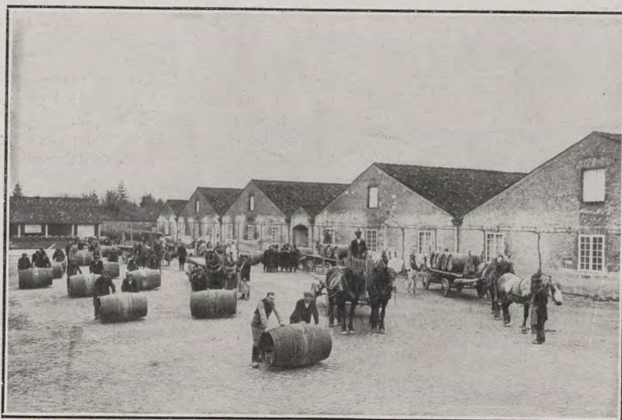
L'ARRIVAGE DES EAUX-DE-VIE
