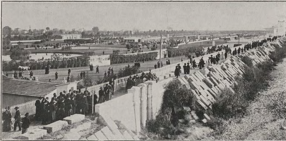
L'ARRIVÉE SUR L'HIPPODROME DU VAR ET LA DIGUE QUI PROTÈGE LE CHAMP DE COURSE CONTRE LES CRUES DE LA RIVIÈRE
