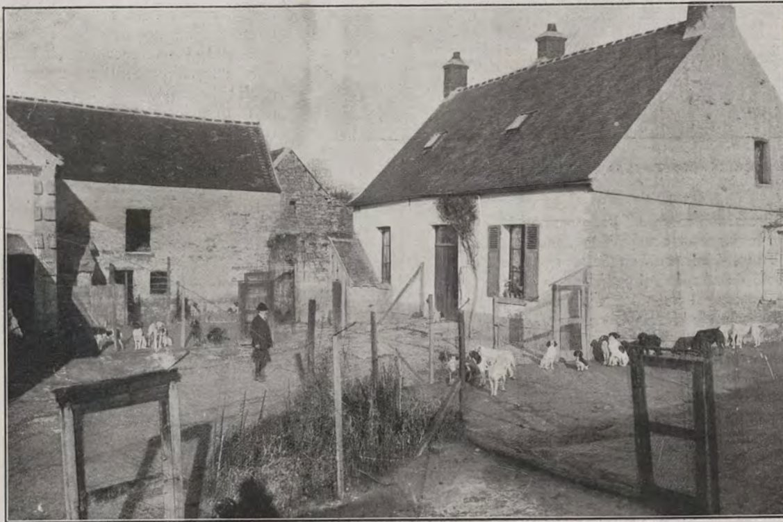
VUE GÉNÉRALE DE L'INSTALLATION COTTEROUSSE
