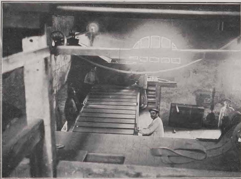
PLAN INCLINÉ FORMÉ DE LAMES DE VERRE SÉPARÉES PAR INTERVALLES OU LES GRAINS RONDS SONT TRIÉS MÉCANIQUEMENT ET SÉPARÉS DES GRAINS DÉFECTUEUX
