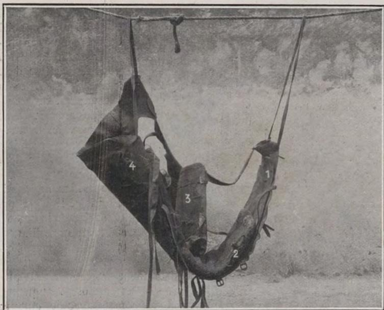
1. Tablier de cuir du poitrail — 2. Matelas rembourré du poitrail — 3. Plaque de tôle rembourrée du poitrail — 4. Tablier de cuir des flancs, à l'intérieur duquel se trouve un matelas rembourré.
