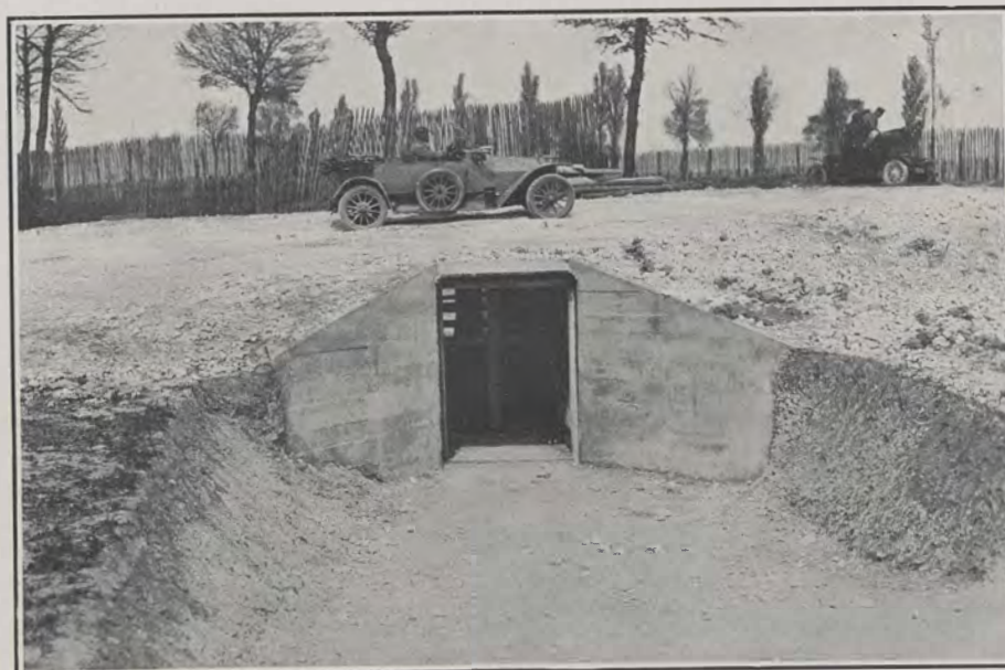
LE PASSAGE SOUTERRAIN QUI VIENT D'ÊTRE CONSTRUIT EN FACE DE L'EMPLACEMENT DES PROCHAINES TRIBUNES DU GRAND PRIX DE L'A. C. F.
